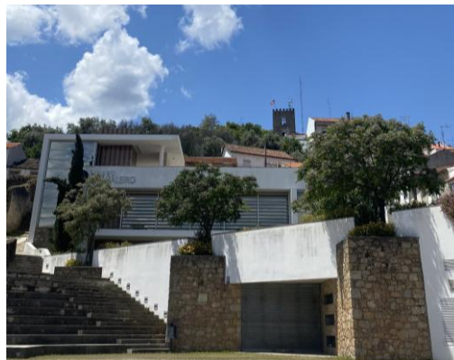
Figura 6- Fachada do 2º edifício
