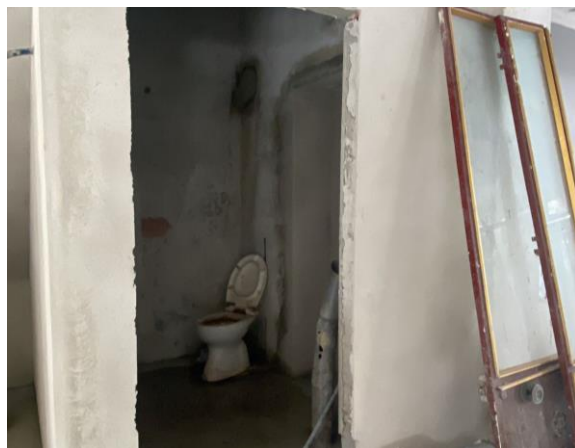
Figura 13- Edifício Rua de Santa Cruz 91, banheiro. Fonte: Augusta Ngonga, 2024.
