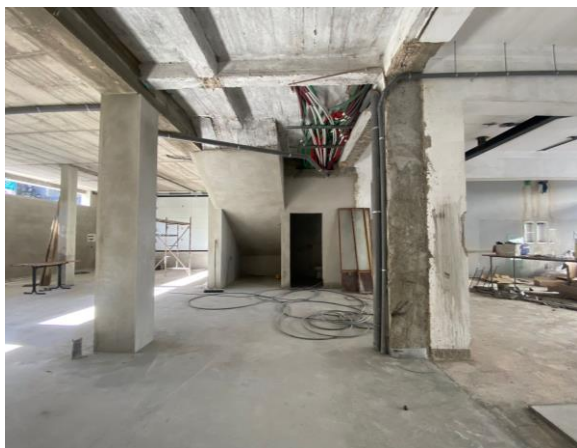
Figura 11- Edifício Rua de Santa Cruz 91, espaço principal e posterior. Fonte: Augusta Ngonga, 2024.
