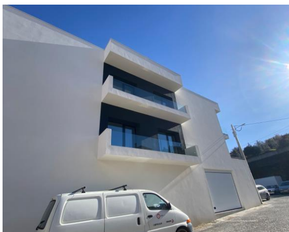
Figura 6- Edifício Rua de Santa Cruz 91, Fachada lateral esquerda. Fonte: Augusta Ngonga, 2024.
