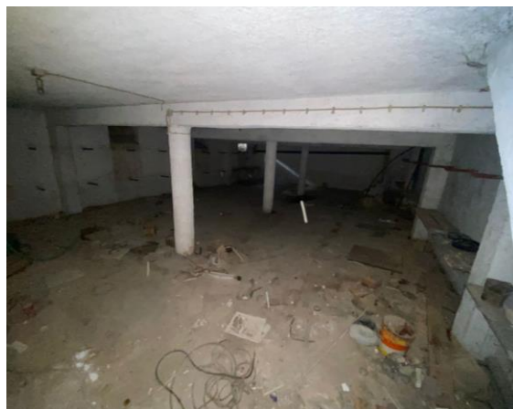
Figura 14- Edifício Rua de Santa Cruz 91, sótão. Fonte: Augusta Ngonga, 2024.
