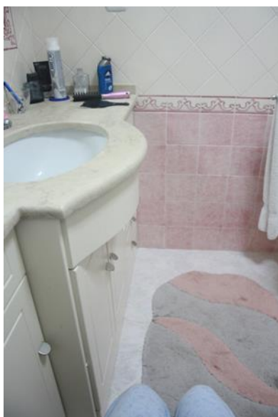
Figura 15- Casa de banho da suite do casal. distância mínima entre a sanita e o lavatório. recorte na bancada, basta uma perda de forças e o idoso corre o risco de bater com a cabeça no recorte do lavatório. (fotografia por Ana Reis)
