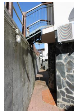
Imagem 16 - Acesso ao piso 0. Fonte: Ana Farinha.
