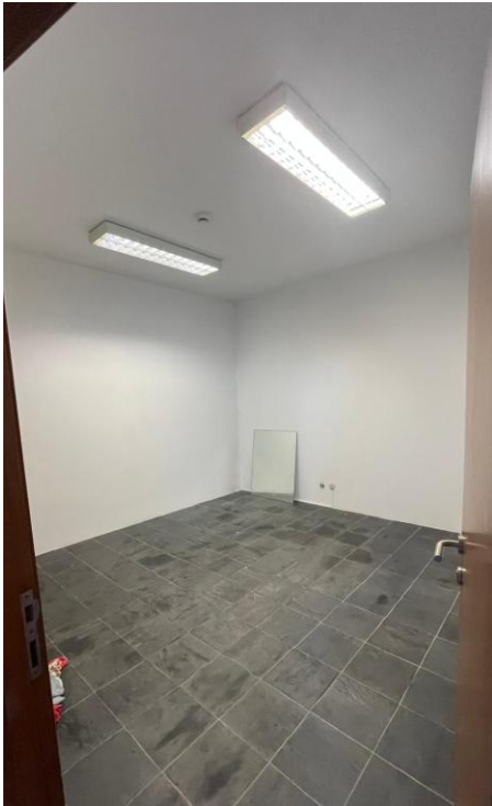
Figura 23- Espaço com instalação sanitária
