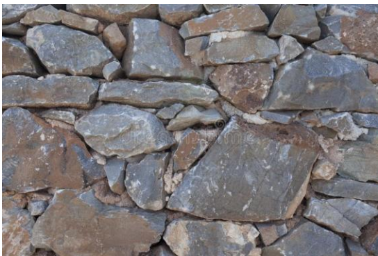
Figura 94- Parede exterior em basalto
