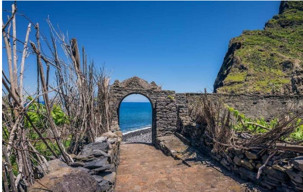
Figura 7 - Pórtico do Calhau de São Jorge
