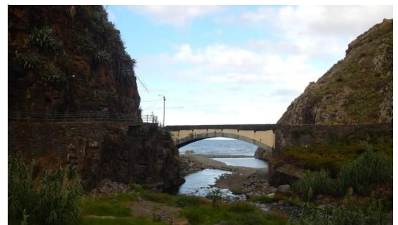
Figura 10- Ponte de acesso para o Restaurante e Zona Balnear
