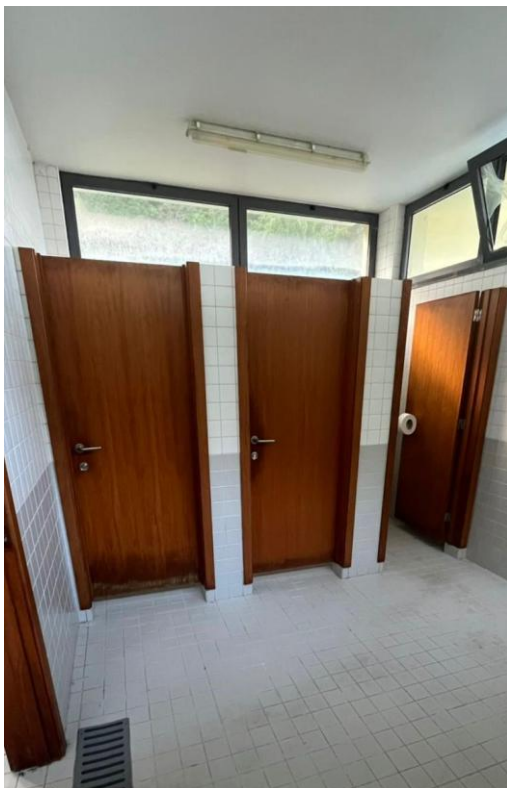
Figura 33- Três Instalações Sanitárias Privadas
