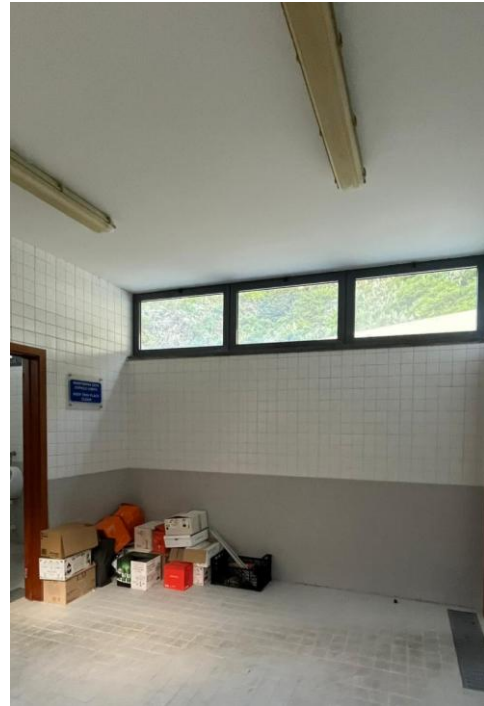
Figura 32- Frente aos lavatórios
