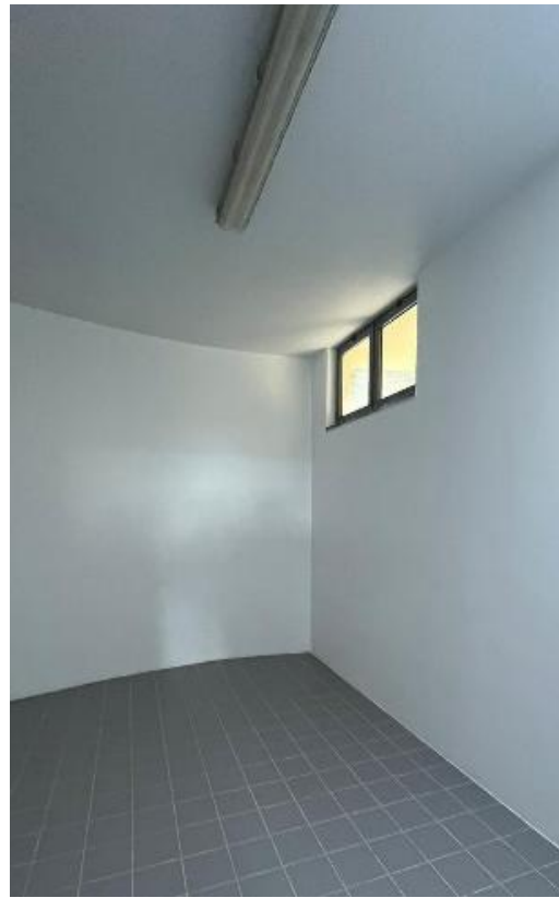
Figura 40- Pormenor da Janela
