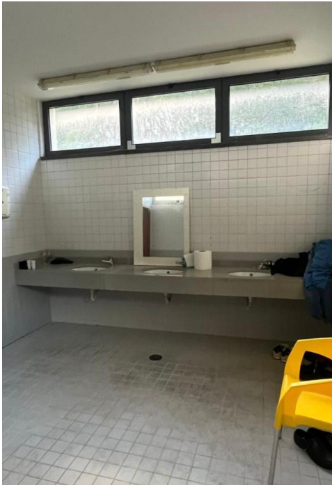
Figura 31- Lavatórios antes dos balneários
