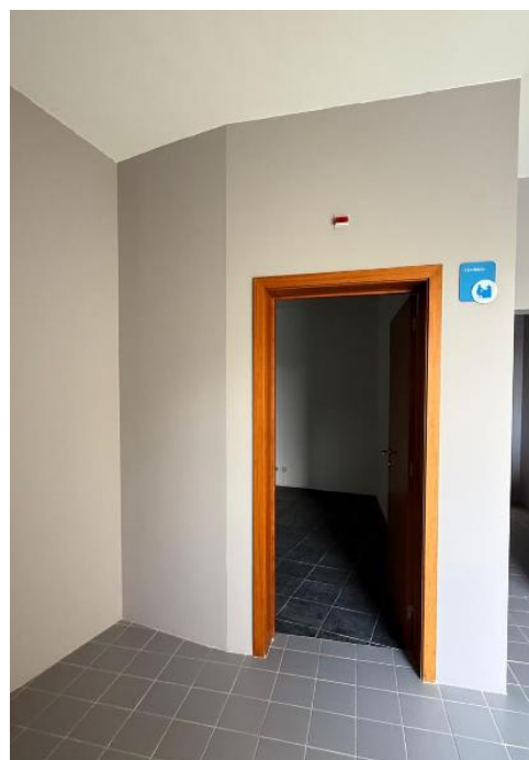
Figura 22- Porta de acesso a um espaço sem janela
