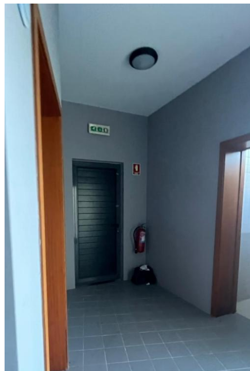
Figura 37- Acesso a uma porta exterior
