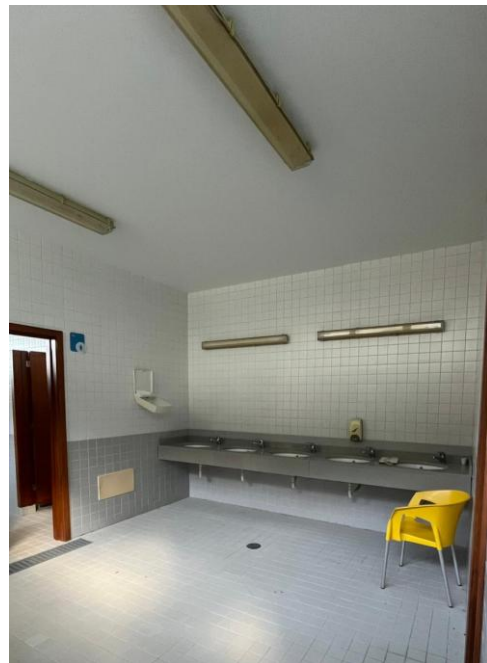
Figura 26- Lavatórios antes do acesso às instalações sanitárias
