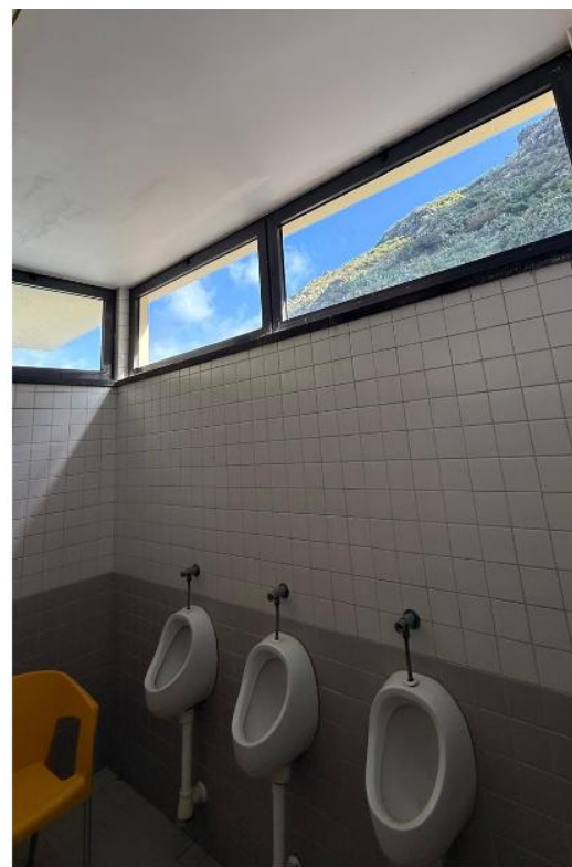
Figura 34- Urinóis em frente às instalações Sanitárias privadas
