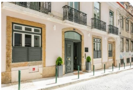
Figura 33 - Fotografia da fachada principal do Almaria - Da Corte Apartments 11
