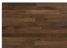
Figura 72 - Pavimento do quartos existente
