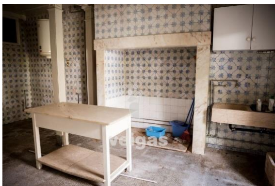
Figura 11 - Fotografia da cozinha existente (vista 1) 5
