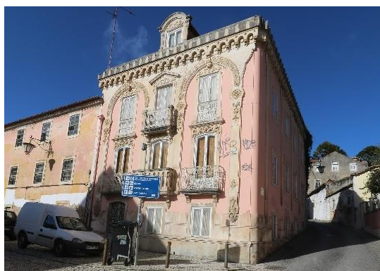
Figura 7 - Fotografia exterior da fachada Sul (principal) do edifício 3
