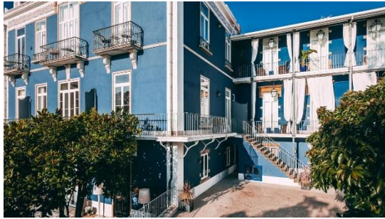
Figura 29 - Fotografia da fachada principal do Torel Palace Lisbon 10
