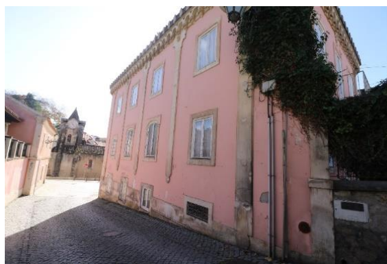
Figura 8 - Fotografia exterior da fachada Este do edifício 3
