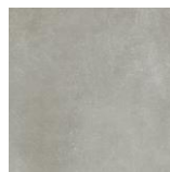
Figura 65 - Pavimento de instalações sanitárias da suite
