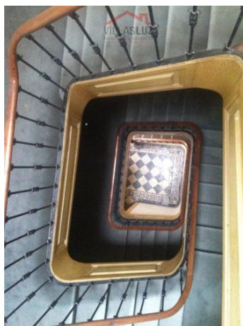
Figura 18 - Fotografia de acesso ao piso 3 7
