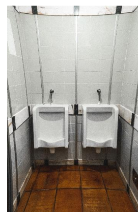
Figura 12 - Casas de Banho masculina - Sala de Refeições
