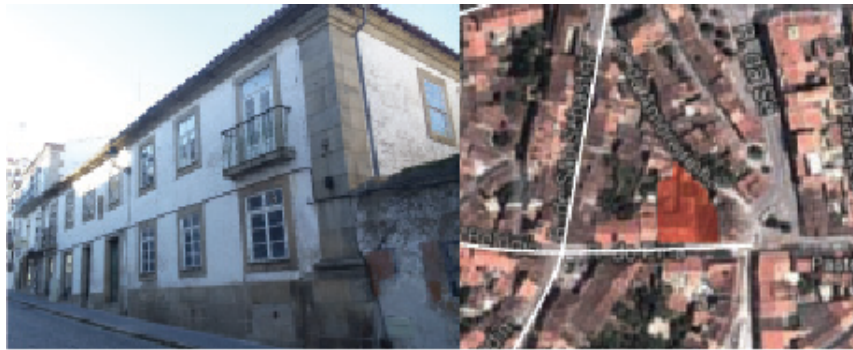
Figura 2: Fachada principal do Solar Proença Tavares Junior e Localização do edifício na malha urbana da cidade.
