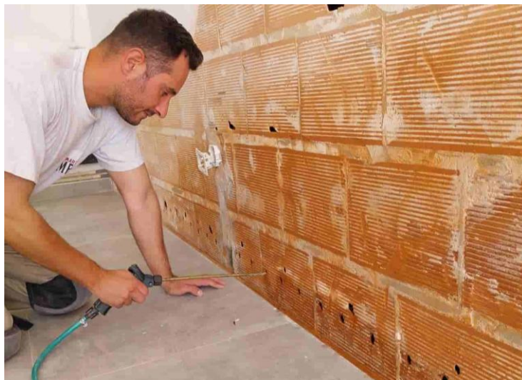
Figura 57. Tratamento de salitre fonte humiseco.pt
