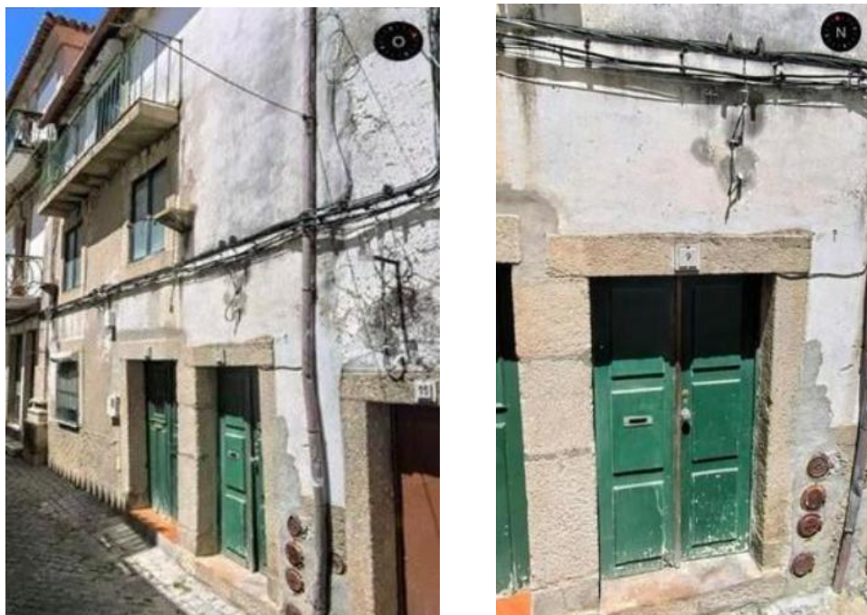
Figura 3. Parte exterior do edifício/ Portas de acesso fonte Leolla Silvestre
