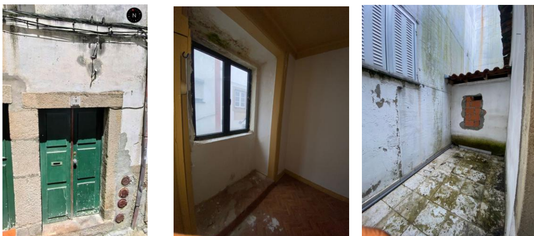
Figura 39. Fachada/Janela/Varanda fonte Leolla Silvestre
