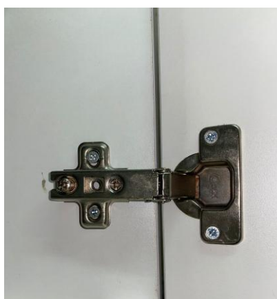
Figura 62. Fixação com parafuso / Pinos de suporte / Dobradiça simples fonte Leolla Silvestre
