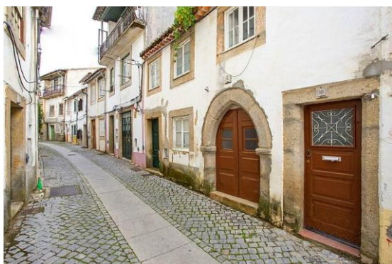
Figura 16. Fachadas da Rua dos Oleiros fonte Pinterest
