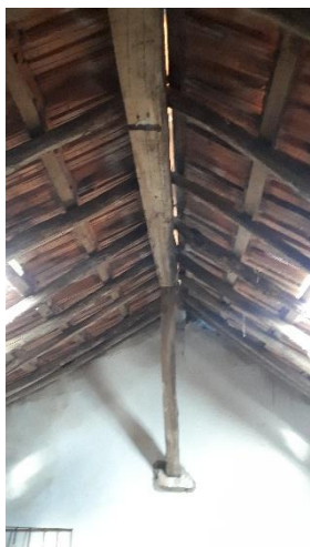
Figura 13- Vista interior do telhado
