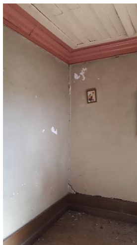
Figura 14- Visualização do descasque das paredes
