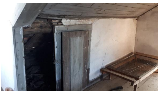
Figura 8- Zona de arrumos
