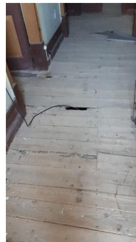
Figura 15- Pavimento da moradia
