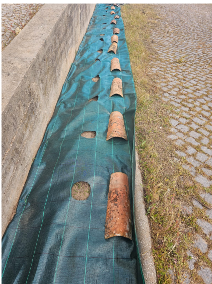
Figura 17 - Colocação da tela.
