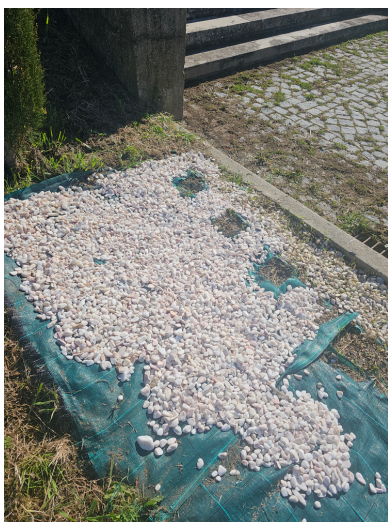
Figura 8 - Colocação de pedra decorativa.
