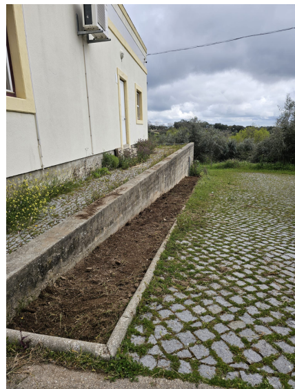
Figura 16 - Canteiro após eliminação de infestantes.
