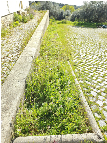
Figura 15 - Canteiro antes de sofrer alterações.
