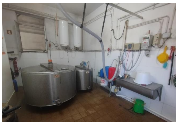
Figura 9- Sala do leite com o tanque de refrigeração
