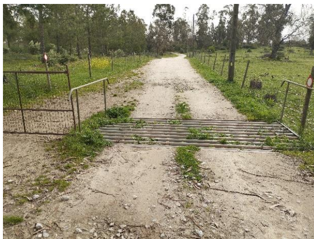
Figura 1- “Barreira canadiana” para impedir a passagem de animais e permitir a passagem de viaturas com rodas
