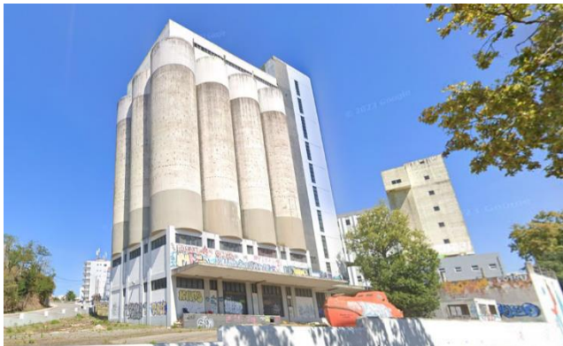
Figura 1- Vista exterior do edifício Silos de Santo Onofre
