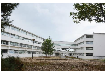
Figura 12 - Fotografia do exterior da ESAD.CR
