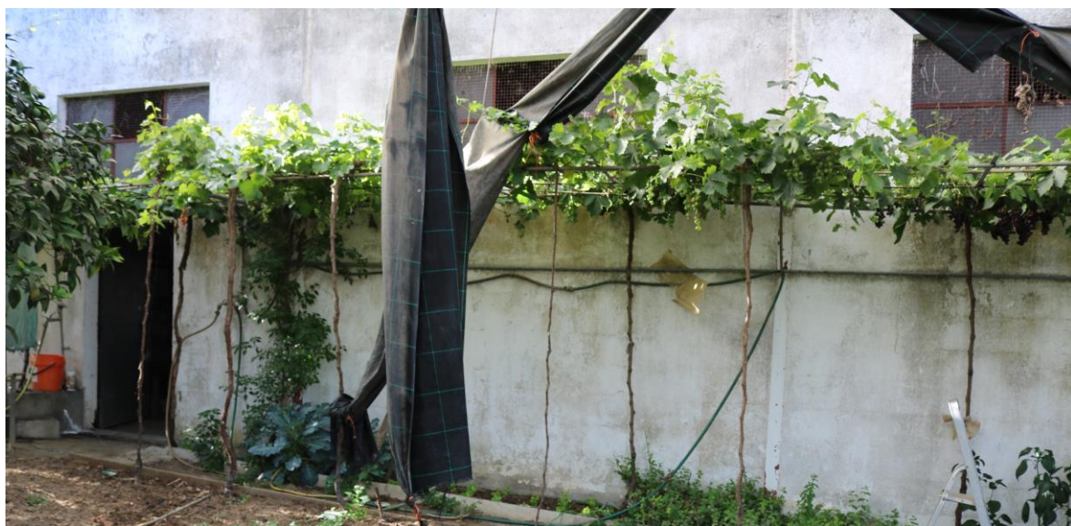
Figura 11 - Fotografias Alçado Sul. Fonte: (Autor)
