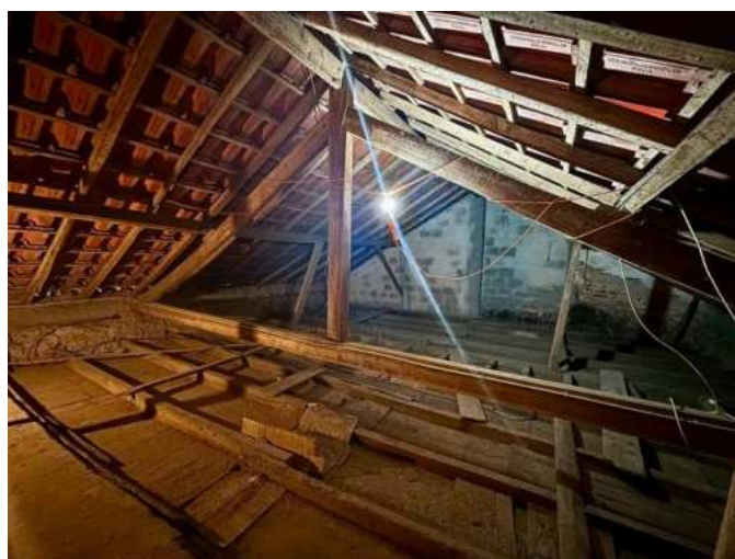
Figura 15 - estrutura do telhado de duas águas existente (Milena Madaleno, 2025)
