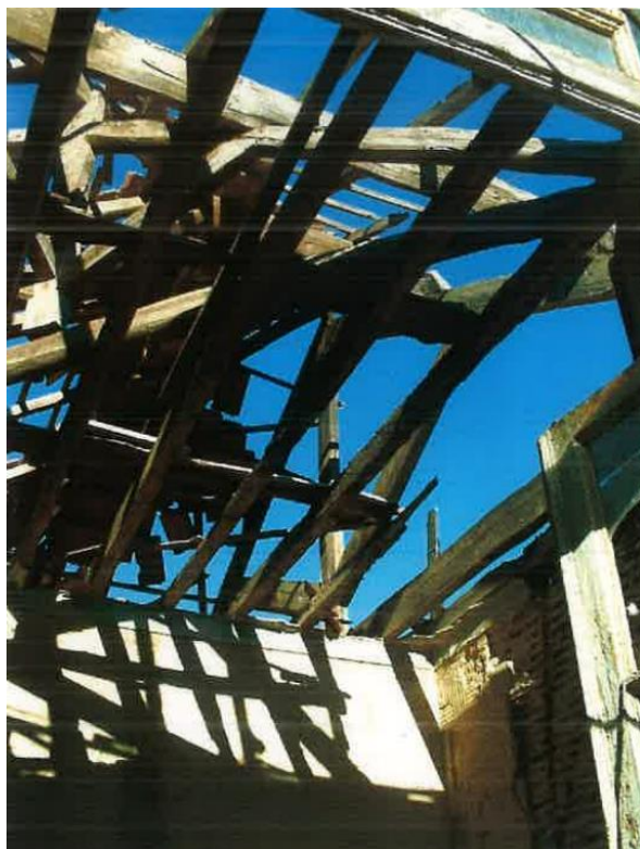
Figura 107 Fotografia da cobertura do edifício. Fonte: ERT
