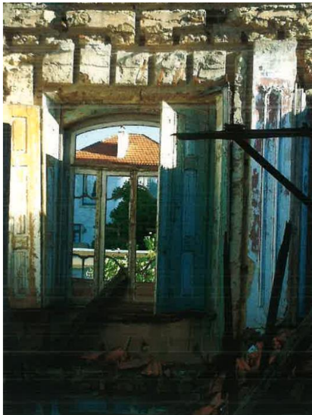
Figura 109 Fotografia do piso 0 do edifício. Fonte: ERT
