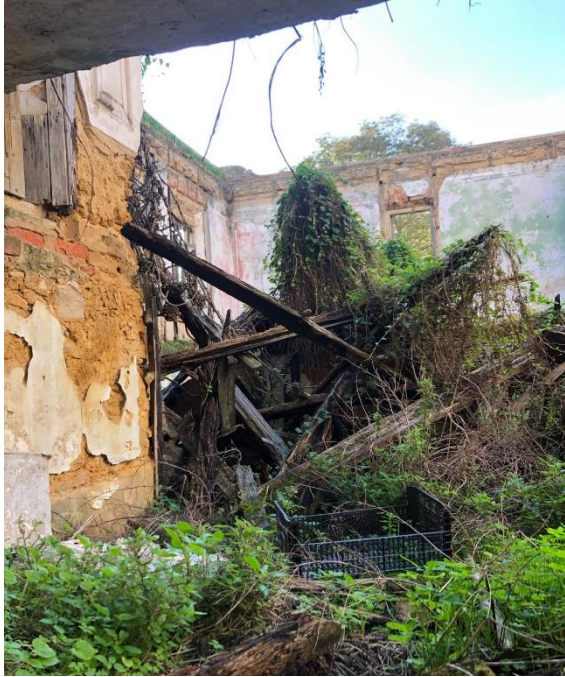
Figura 5- Fotografia do interior do edifício, em 2023. Fonte: Autor
