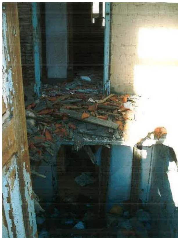
Figura 110- Fotografia dos dois pisos do edifício. Fonte: ERT
