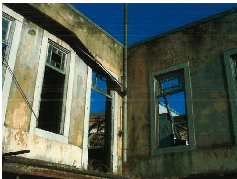
Figura 108 Fotografia do interior do edifício. Fonte: ERT
