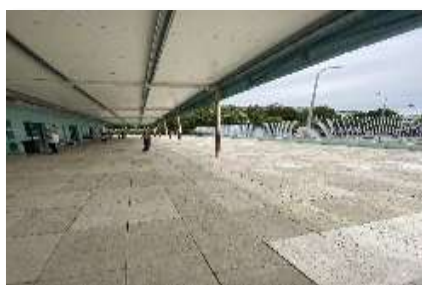
Figura 14 - Área Exterior da Escola São Tiago
