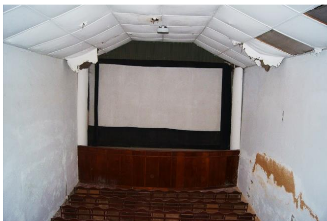
Imagem 34: Cinema Olímpia. Vista interior. (Fotografia de Autor)
