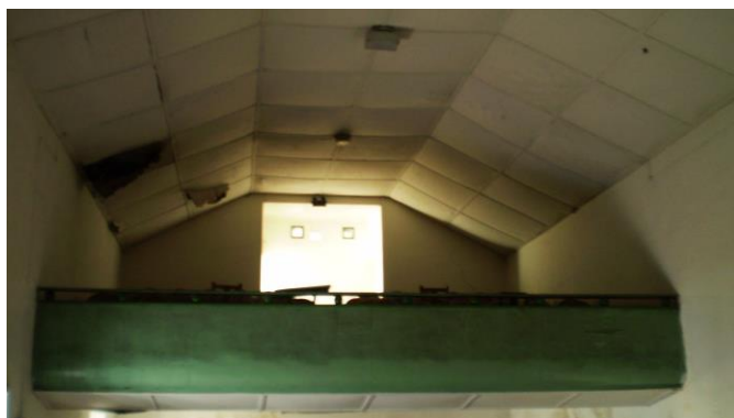
Imagem 15 (à esq) - Cinema Olímpia. Vista de baixo do primeiro balcão.
