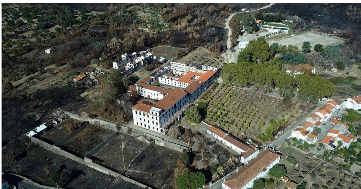
Figura 4 – Colégio de São Fiel depois do incêndio de 2017
