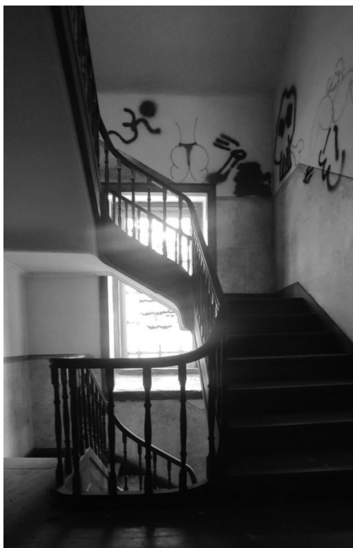
Figura 19 - Edifício vandalizado | Beatriz Figu
