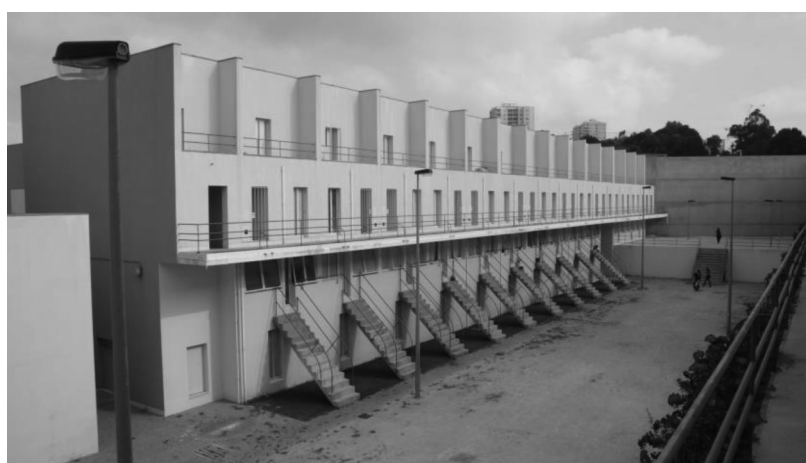
Figura 31 - Exterior Bairro da Bouça | Álvaro Siza
