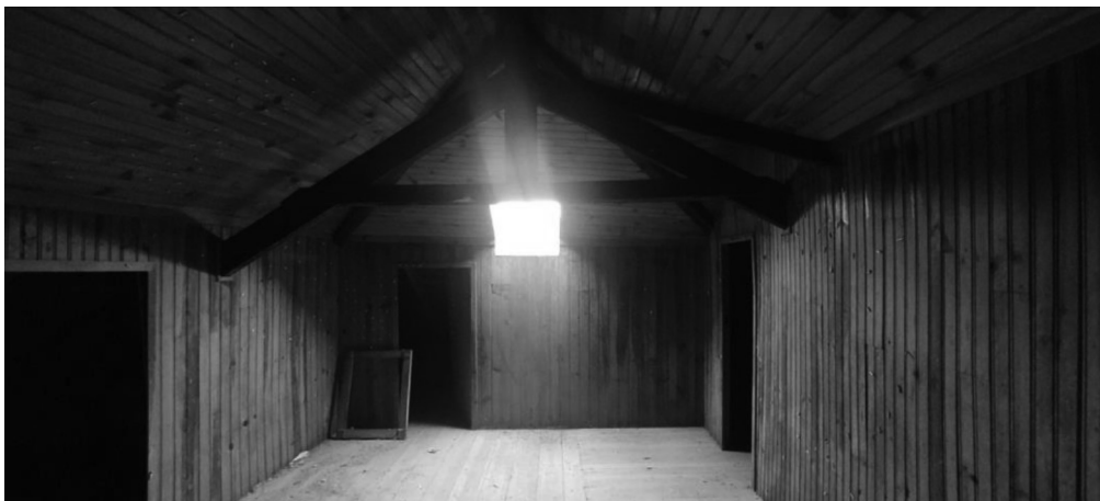
Figura 12 - Sótão da Casa Castelo | Beatriz Figueiredo
