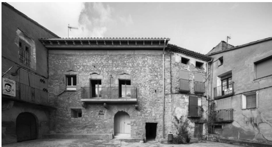
Figura 47 - Edifício Cal fuster | Marc Díaz
