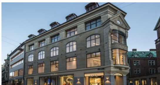
Figura 31 - Fachada Zara (Copenhaga);
