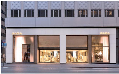
Figura 33 - Fachada Zara (Índia);
