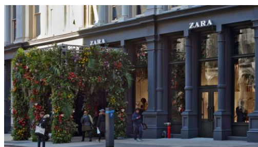
Figura 29 - Fachada Zara (Nova Iorque);
