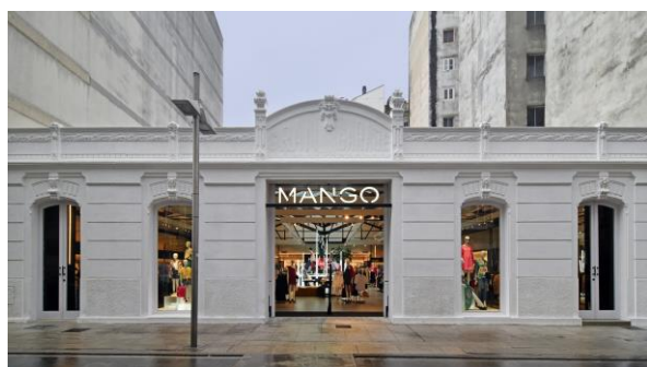
Figura 66 - Fachada Mango (Localização desconhecida);
