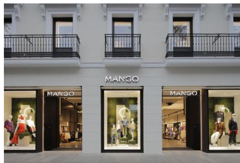
Figura 67 - Fachada Mango (Localização desconhecida);
