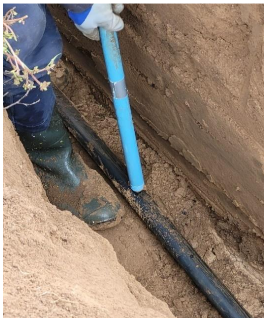
Figura 11 - Colocação de união
