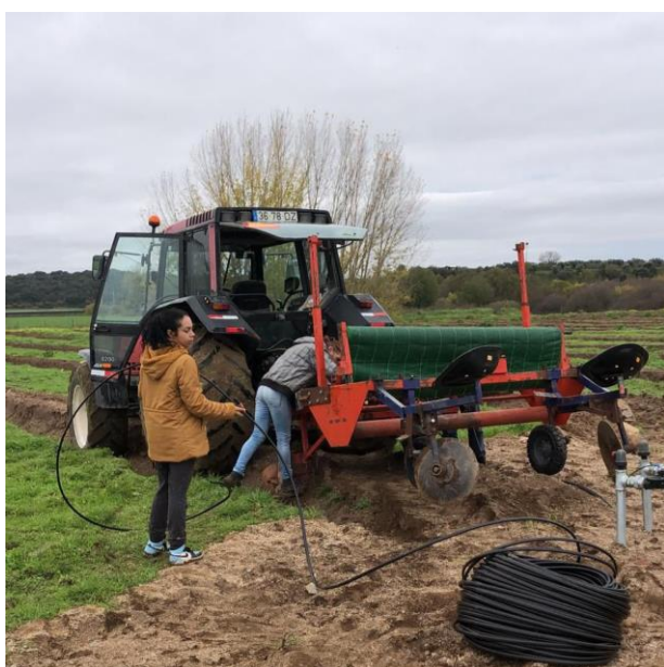
Figura 4 - Colocação de tela e tubo de rega
