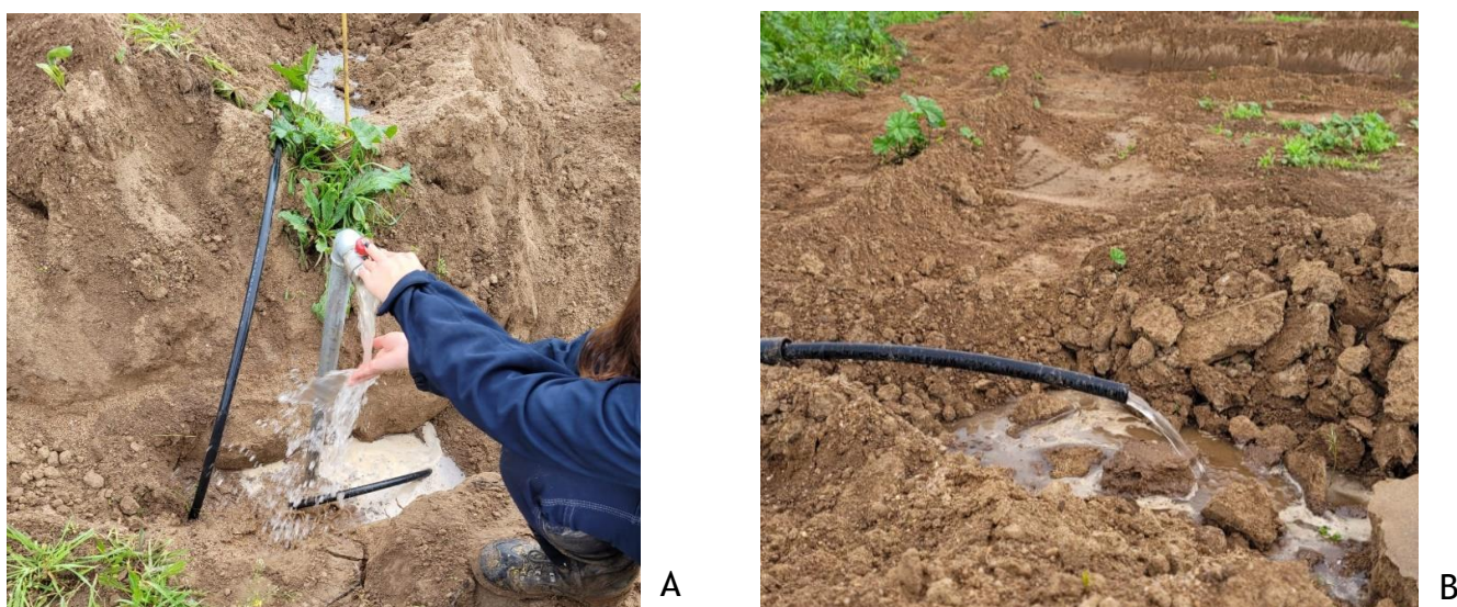
Figura 13 - Lavagem do sistema (purga) (A) e tubagens (B)
