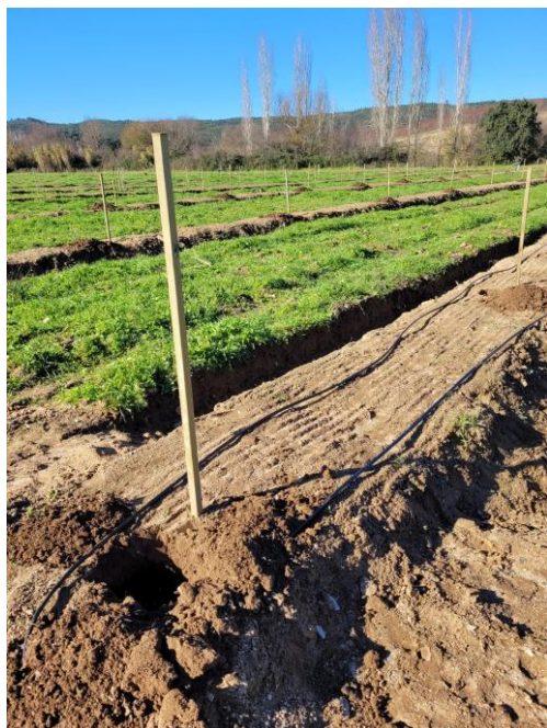
Figura 18 - Abertura para plantação
