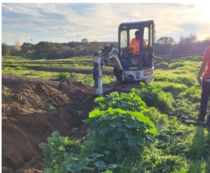
Figura 8 - Abertura de vala
