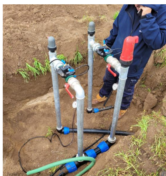
Figura 9 - Instalação de cabeçais de rega (A e B)
