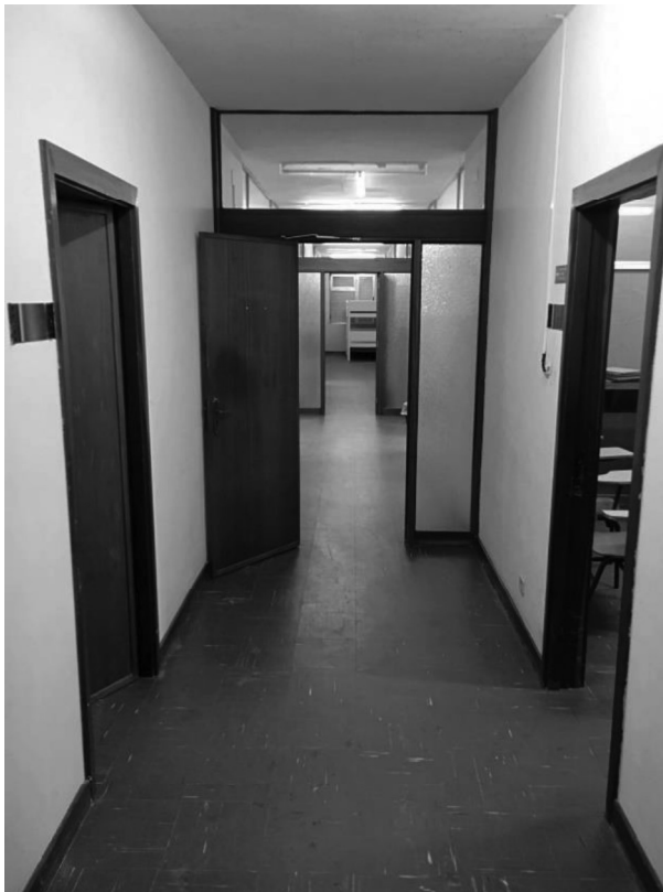
Figura 8- Corredor do lado esquerdo. Fonte: Autora
