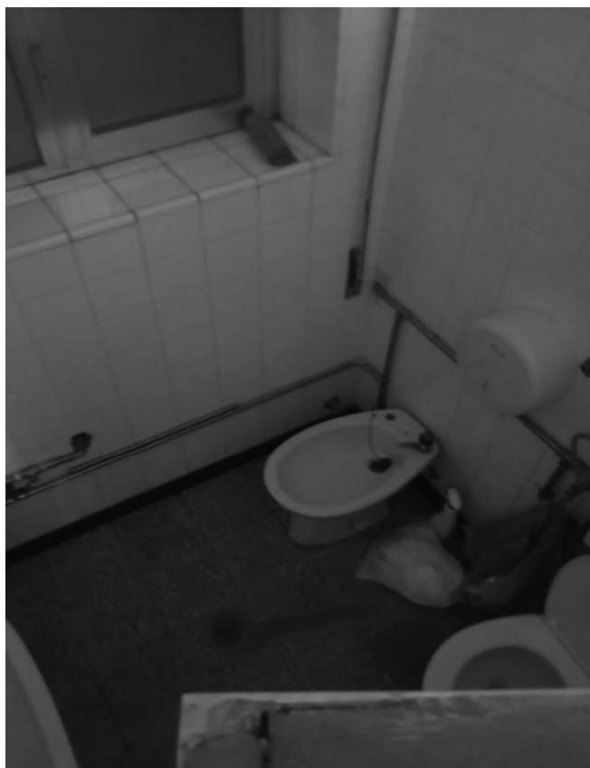
Figura 14- Casa de banho. Fonte: Autora
