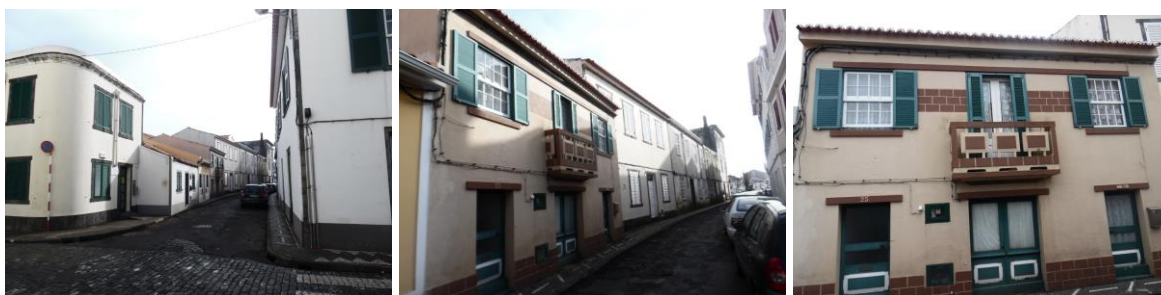
Figura 10 - Rua e fachada da moradia.
