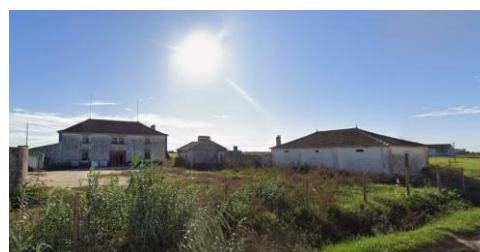
Figura 11 – Vista frontal do edifício. Google Maps. (2025)
