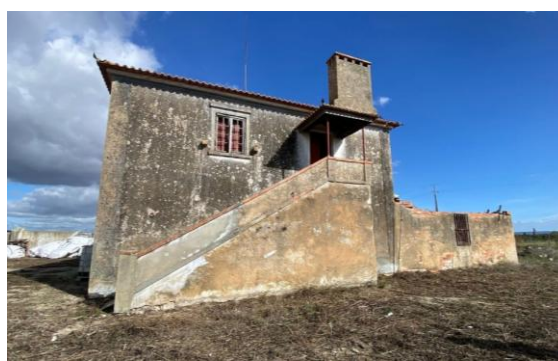
Figura 13 – Alçado Lateral direito do edifício. Silvestre (2026)
