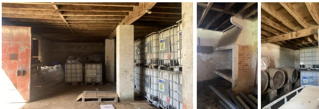
Figura 14 – Interior do piso 0 Edifício principal. Silvestre (2026)
