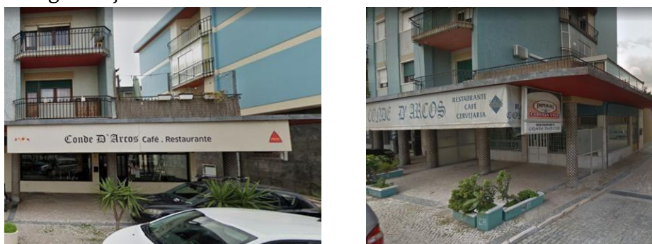
Fig. 9 e 10 – Entrada do edifício e vista do exterior (fonte: Google maps)
