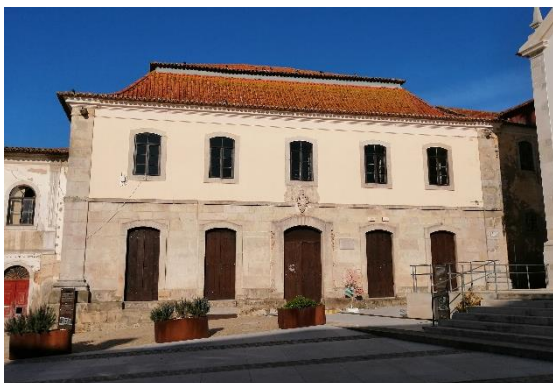
Figura 25 Fachada principal Fonte: Adriana Monteiro
