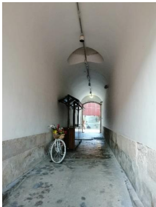
Figura 29 Túnel Fonte: Adriana Monteiro
