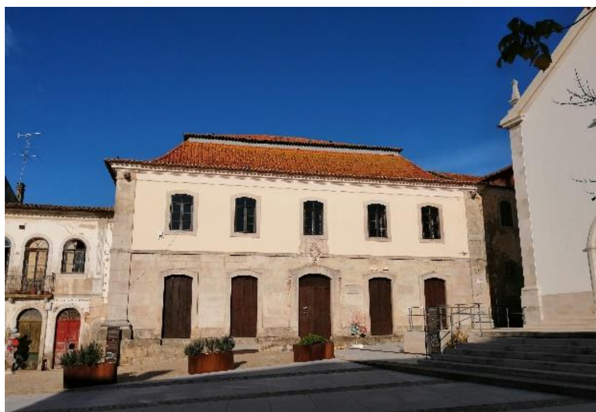
Figura 2 Fachada Principal Fonte: Adriana Monteiro
