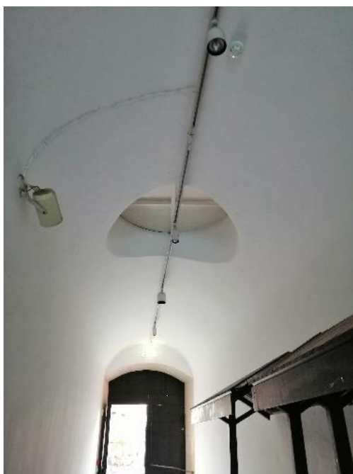
Figura 31 Furação de acesso ao 1º andar Fonte: Adriana Monteiro
