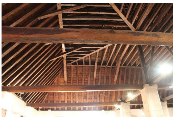
Figura 38 Pormenor da estrutura de suporte do telhado Fonte: Adriana Monteiro
