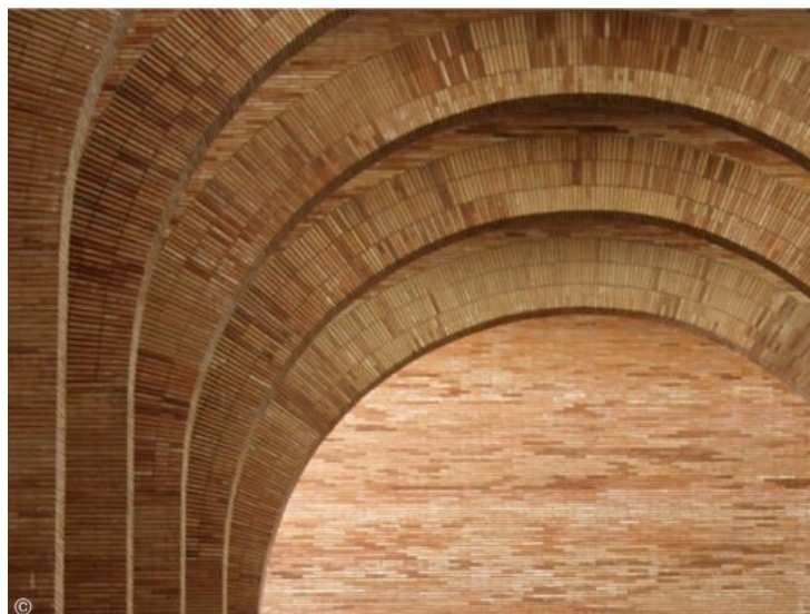
Figura 18 Pormenor dos arcos marcados pelo ritmo do tijolo Fonte: https://www.plataformaarquitectura.cl/cl/766772/clasicos-de-arquitectura-museo-nacional-de-arte-romano-rafael-moneo
