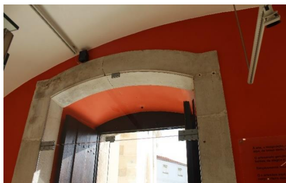
Figura 84 Detalhe de cantaria nos vãos Fonte: Adriana Monteiro
