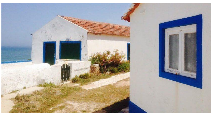
Figura 9 - Habitações construídas em volta da Ermita.
