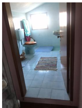
Figura 22 -Instalação sanitária 3, autora: Maria Santos
