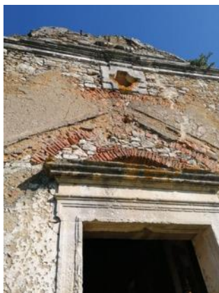
Figura 3- Pormenor da fachada principal, ano de 2020; Fonte: Mariana Vieira.
