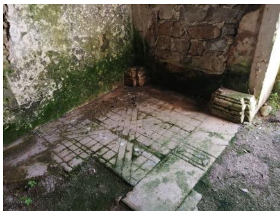
Figura 26- Pavimento da nave, ano de 2020; Fonte: Mariana Vieira.
