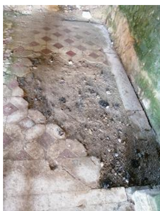
Figura 38- Pavimento da capela-mor, ano de 2020; Fonte: Mariana Vieira.
