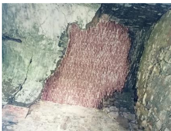
Figura 15- Diferença da reconstrução da cobertura, ano de 2020; Fonte: Mariana Vieira.
