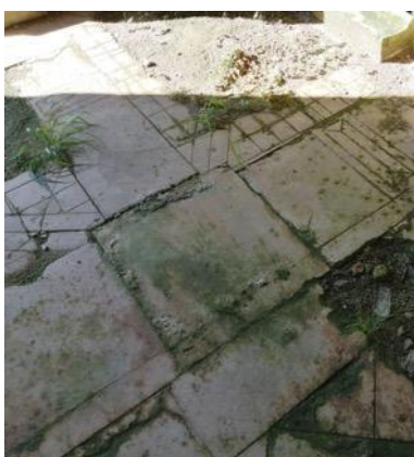
Figura 39- Pavimento da nave, ano de 2020; Fonte: Mariana Vieira.
