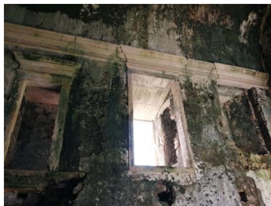
Figura 9- Janelas do lado sul, corredor interno, ano de 2020; Fonte: Mariana Vieira.
