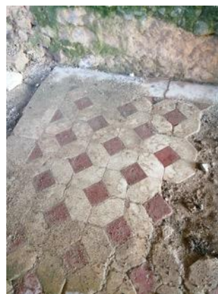
Figura 27- Pavimento da capela-mor, ano de 2020; Fonte: Mariana Vieira.
