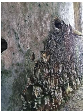
Figura 23- Marcas da antiga escada, ano de 2020; Fonte: Mariana Vieira.
