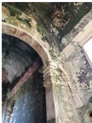
Figura 10- Arco de divisão da nave e da capela-mor, ano de 2020; Fonte: Mariana Vieira.
