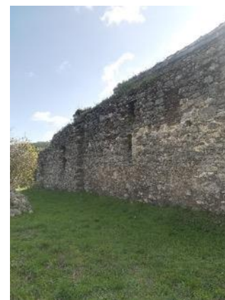
Figura 7- Fachada a norte, ano de 2019; Fonte: Mariana Vieira.
