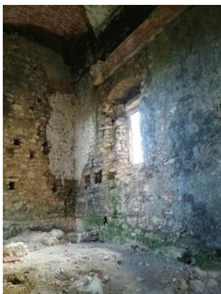
Figura 16- Abertura a sul da capela-mor, ano de 2020; Fonte: Mariana Vieira.
