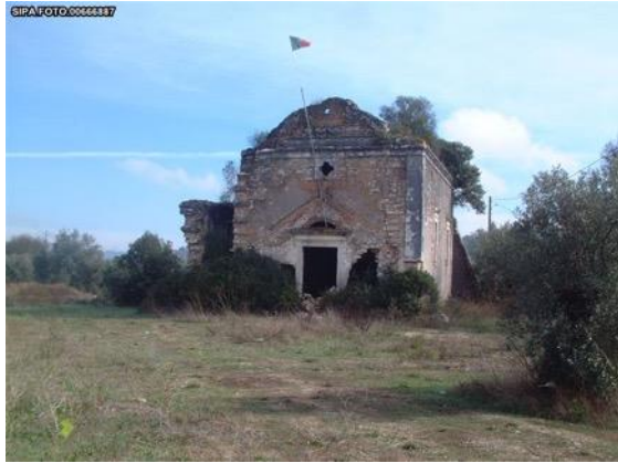
Figura 28- Exterior da capela, ano de 2004; Fonte: DGEMN/DSID.
