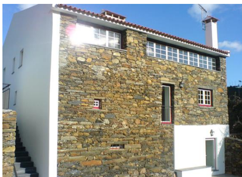
Figura 8 - Fachada exterior com xisto
