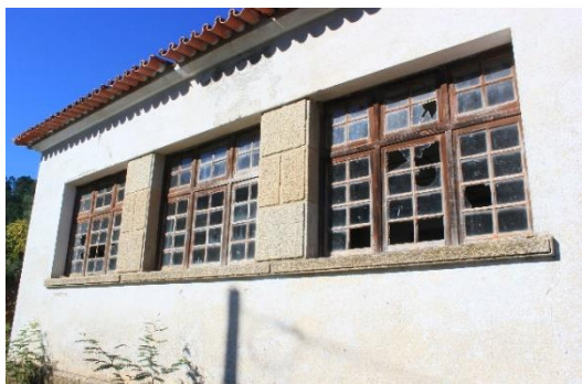
Figura 13 - Fachada principal da escola
