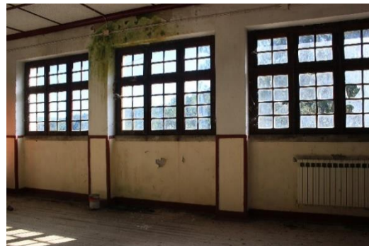
Figura 14 - Antiga sala de aulas
