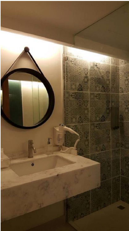
Figura 12 - Lub d Phuket – Instalação Sanitaria
