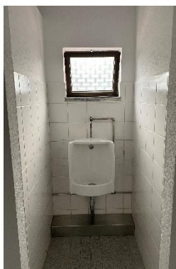
Figura 11- Instalação sanitária masculina Fonte: Autor
