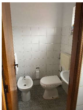
Figura 9- Instalação sanitária feminina Fonte: Autor
