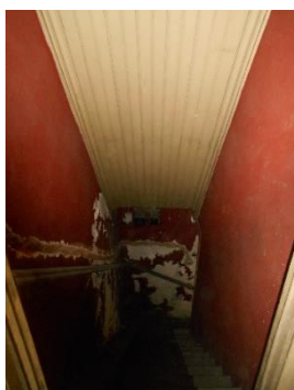
Figura 11 - Acesso ao piso superior
