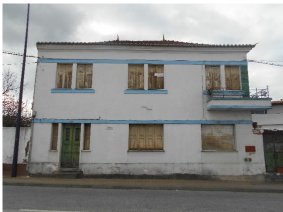
Figura 1 - Fachada principal do edifício a intervir
