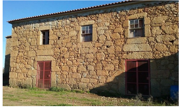
Figura 4_ Vista exterior da habitação (traseiras)
