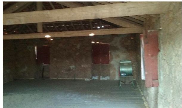
Figura 6_ Interior atual da zona proposta para escritório
