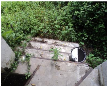
Figura11- Escadas de acesso ao jardim.
