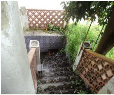
Figura 10- Escada exterior que dão acesso ao piso superior.
