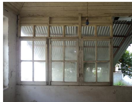
Figura14- Janelas da marquise.
