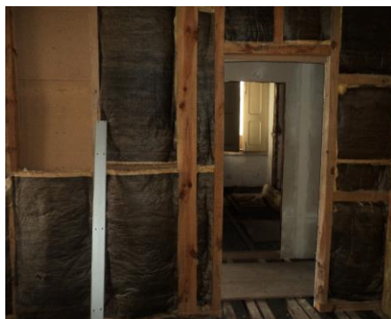
Figura 16 -Revestimento das paredes, piso 1.
