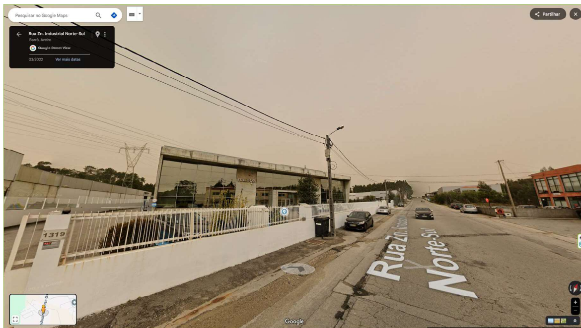
Figura 3 - Imagem do exterior edifício da Italbox
