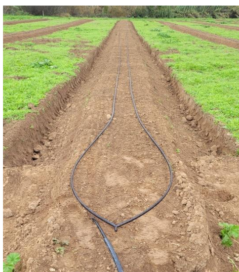
Figura 14 - Instalação da tubagem com gotejadores
