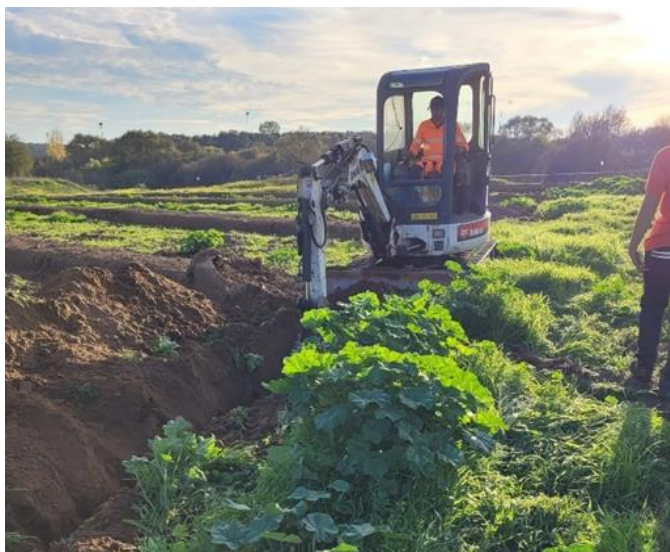
Figura 8 - Abertura de vala
