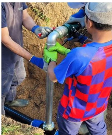
Figura 9 - Instalação de cabeçais de rega (A e B)
