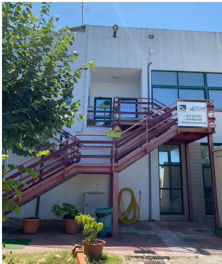
Figura 13 - Instalações TRAVEMESTRA, Lda
