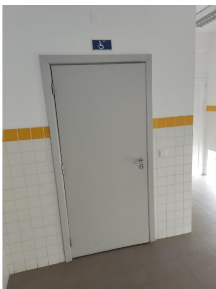
Figura 13 Casa de banho dos deficientes
