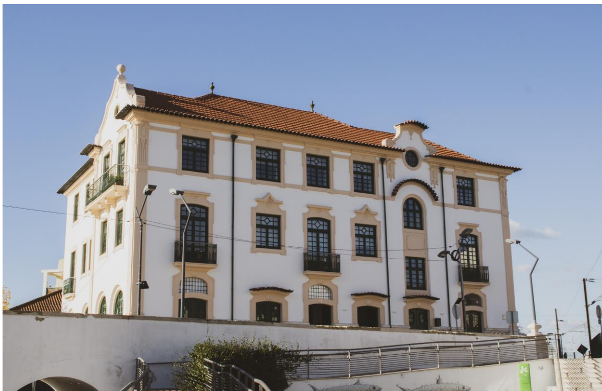
Figura 4 - Fotografia do Edifício “Casa Varela”. Fonte: Autor
