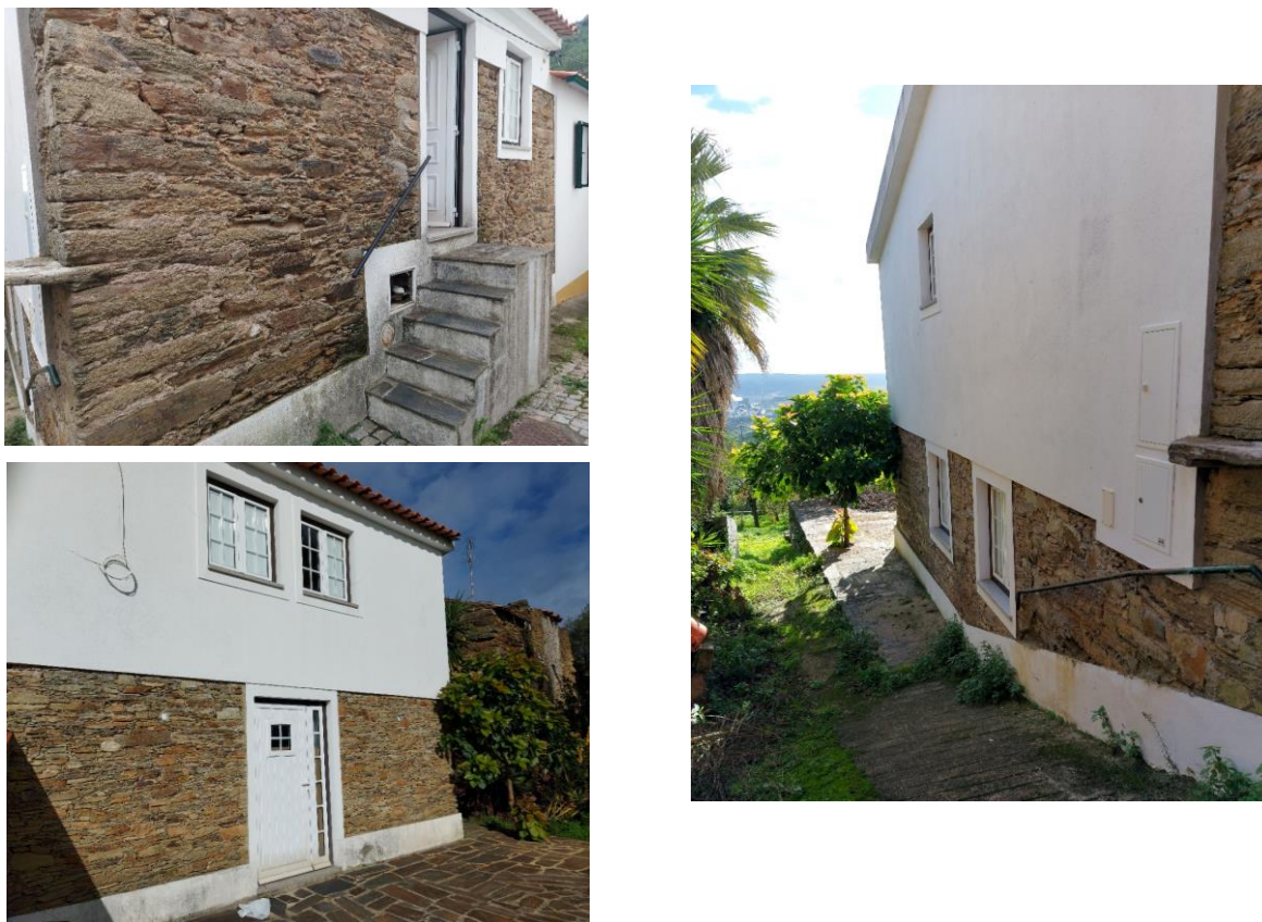
Figura 6 - Fotografia do exterior do espaço. Fonte: Maria Leonor.
