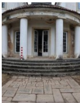
Figura 1- Entrada edifício. Fonte: Joana Carrilho.
