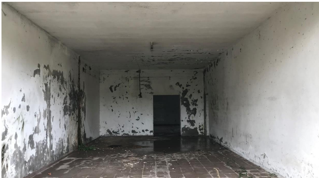
Imagem 26- Zona de cargas e descargas
