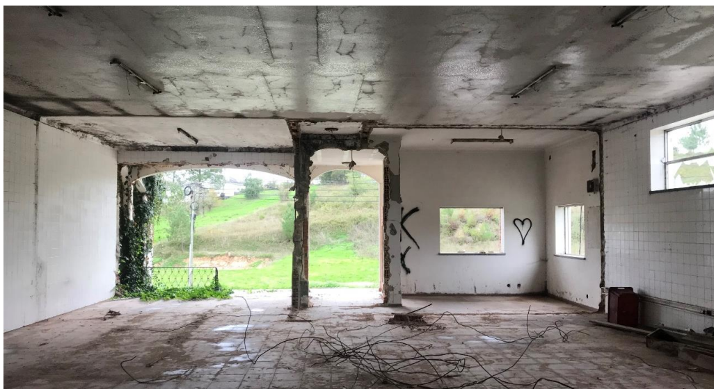
Imagem 16- Vista da fachada principal a partir do interior
