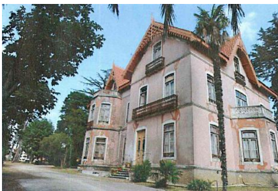
Figura 2 - Vista do alçado principal
