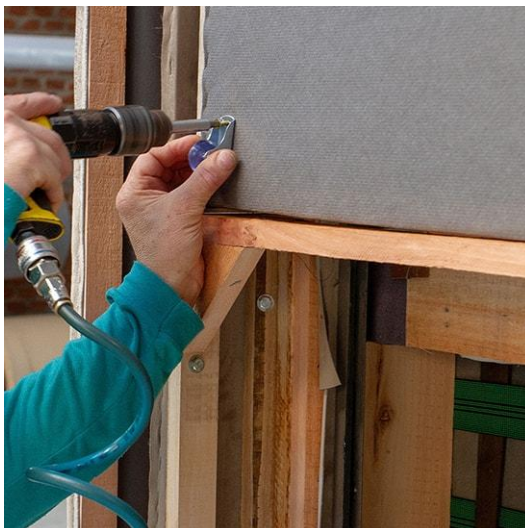
Figura 81 - Processo de montagem
