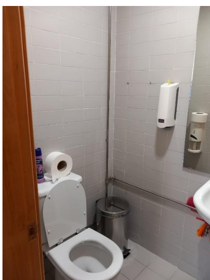
Figura 15. Wc feminino - vista 1. Fonte: Autor
