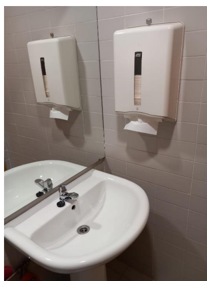
Figura 16. Wc feminino - vista 2. Fonte: Autor
