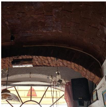
Figura 13-Tectos em tijolo burro à vista
