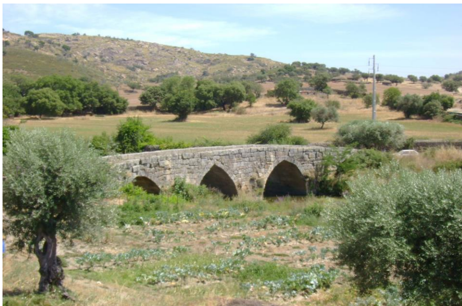
Figura 46. Ponte de Monsanto
