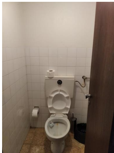
Figura 13 – Casa de banho masculina (sanita)
