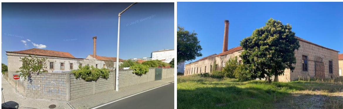
Figura 16 - Edifício visto da rotunda; Entrada do antigo lagar. Fonte: Google Maps
